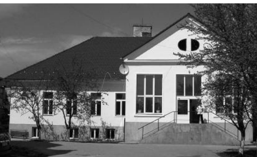
Renovierter Altbau in Beclean
